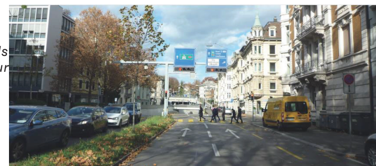
Guide VSS 2016, Profils de routes ayant fait leur preuve, Murtenstrasse (Berne; 50 km/h, 17'000 TJM). 2 x 5.50 m pour 2 voies bidirectionnelles mixtes (bus, voitures)
